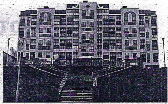
Начать строительство планировали в следующем году. Рядом будет большая открытая спортивная площадка с амфитеатром.
